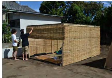
鶏小屋風シェルターをつくった男子3人チーム。掘立て柱で頑丈です。シェルター裏側と天井を防虫ネットにして開放感を演出しましたが、降雨には勝てず。翌日雨対策を施すも、またもや雨に打ち負かされて退散。
